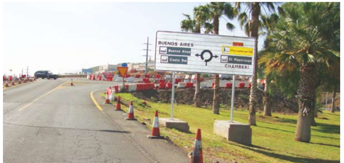
Lamentable estado de demasiados tramos en obras interminables.
